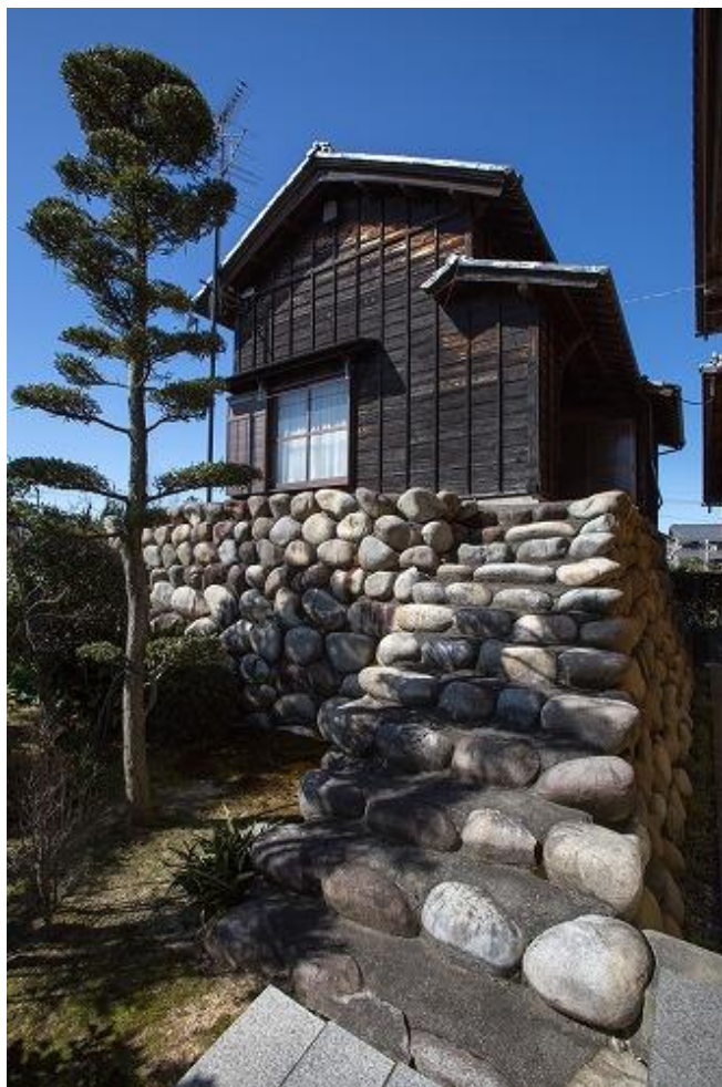
写真1：辻邸の水屋・水塚（岐阜県大垣市米野町）
