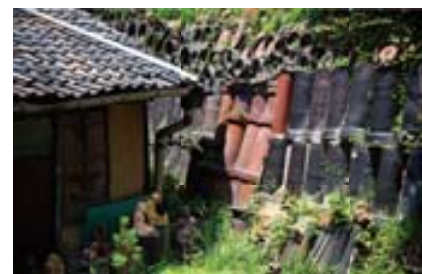
土管でできた土留め
