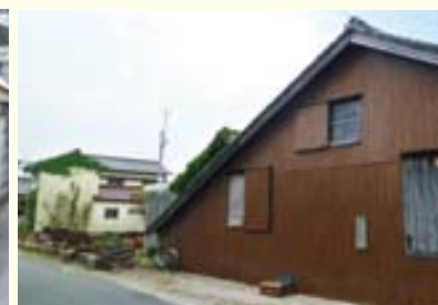
大きな屋根と藁の絡まる妻壁
