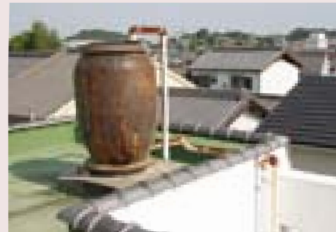
餅菓子店「井桁屋」の屋上
