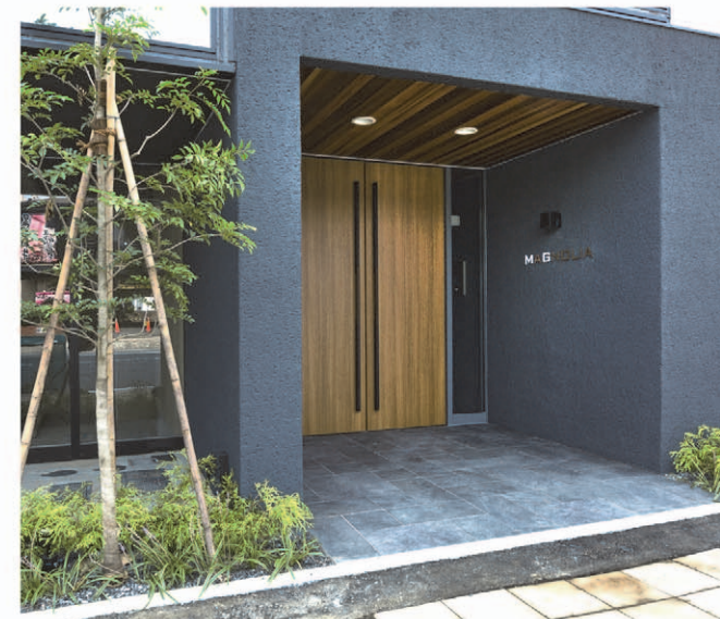
壁面を塗り壁で仕上げたエントランス
