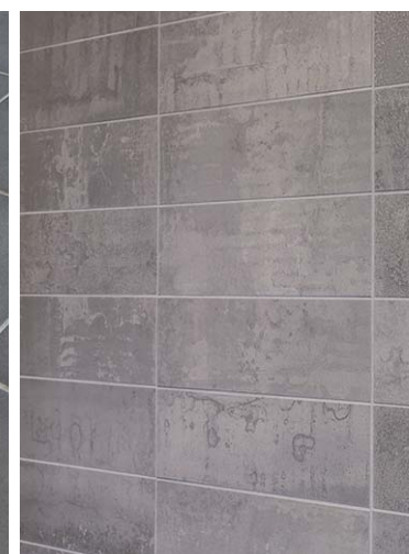
男性用トイレ 壁タイル
