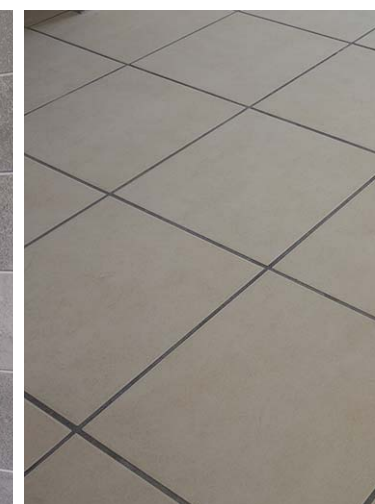
女性用トイレ 床タイル
