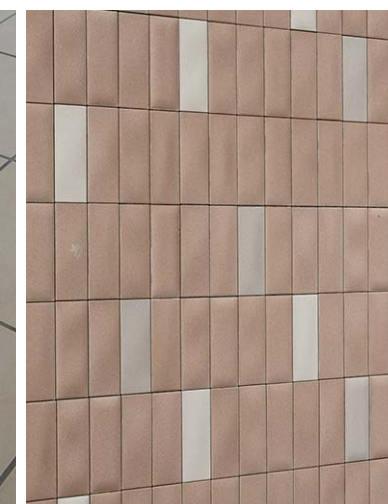
女性用トイレ 壁タイル
