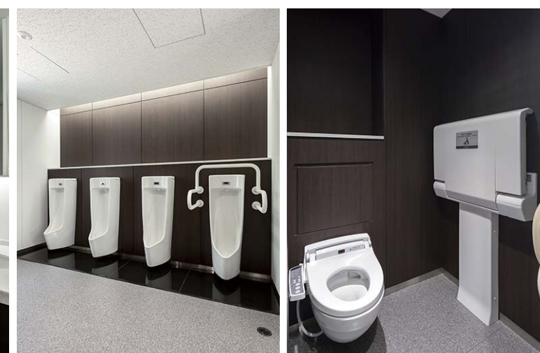
鏡裏照明が浮遊感を演出。おむつ交換台も設置し、子ども連れでも安心して利用することができる。小便器はシンプル形状で拭き掃除がしやすく、便器下には尿垂れを考慮した汚垂石を設置し、床の清掃性を向上させている。
