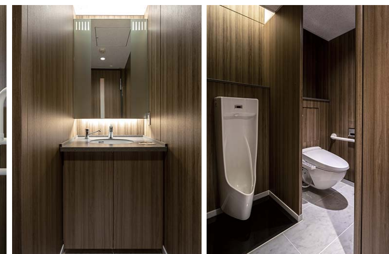
貴賓室には小便器も備えた個室トイレを併設。木目を基調とした室内には、他のトイレと同様に壁掛タイプの便器を採用し、清掃性に考慮している。
