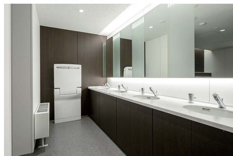
鏡裏照明が浮遊感を演出。おむつ交換台も設置し、子ども連れでも安心して利用することができる。小便器はシンプル形状で拭き掃除がしやすく、便器下には尿垂れを考慮した汚垂石を設置し、床の清掃性を向上させている。
