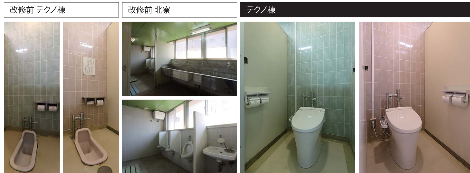
改修前 テクノ棟 (左) 男性用トイレ、(右) 女性用トイレ (上) 洗面エリア、(下) 小便器エリア テクノ棟 便器を和式から洋式に交換。トイレ環境の改善に伴う利用者の使い勝手の向上はもちろん、ランニングコストの削減も実現。
